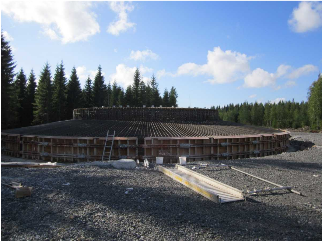
Kuva 7-4 Kuvassa esimerkki tuulivoimalan perustusten rakentamisesta
